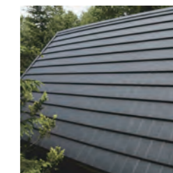
軽量で高強度の 鋼板パネル
